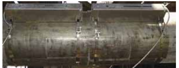
Накладные датчики в защитных кожухах
