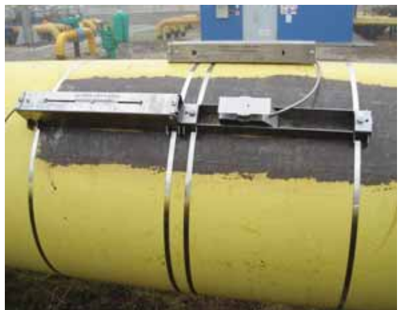
Процесс установки накладных датчиков
